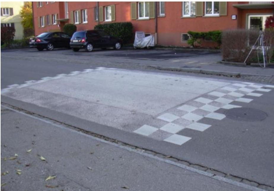
Figure 16 : Exemple pour un décrochement vertical
