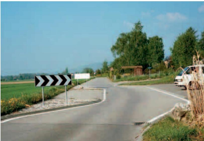
*Figure 17 : Exemple pour un décrochement horizontal*
